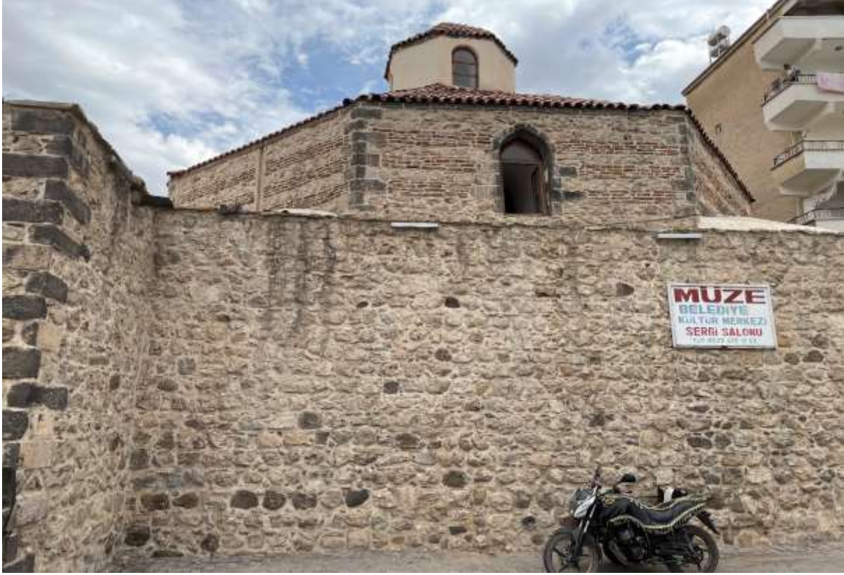
Çermik Saray Hamamı dış görünümü
